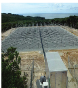
Figura 4 – Perfilador de Vento.
